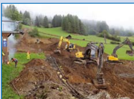
„Aufbruchsstimmung in St. Michael“ Die Bauarbeiten der „Sonnenbahn“ haben begonnen!
